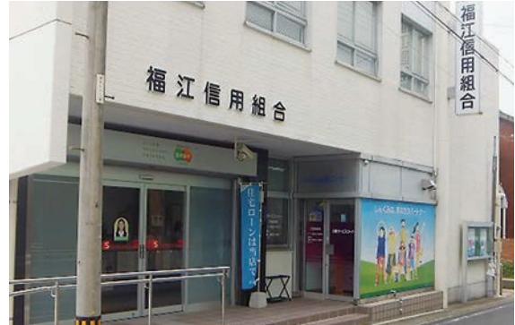
本店建物外観
